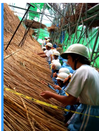
池田小学校の地域学習 （文化財修復工事現場の見学）
