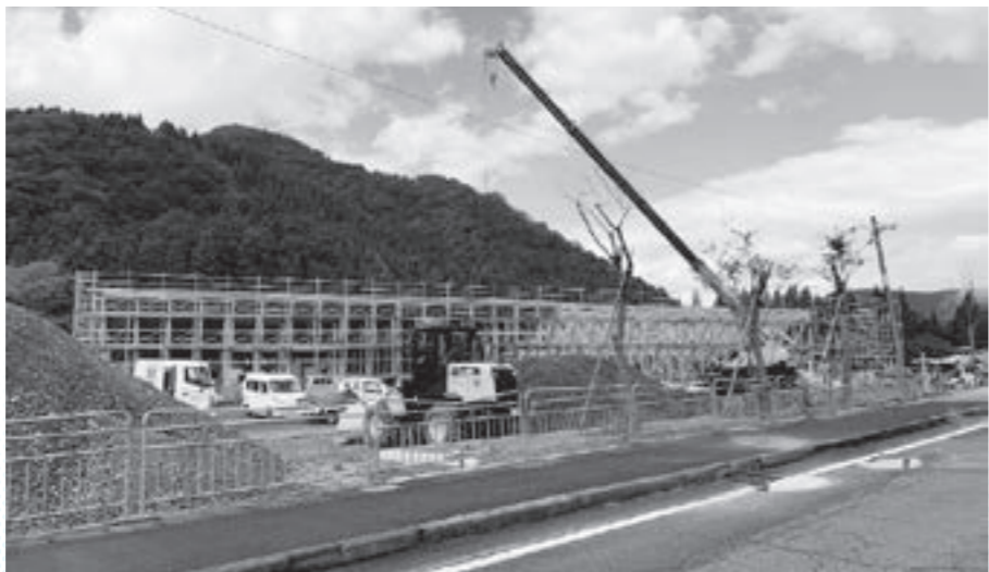
▲整備が進むフォアシーズンテラスの工事現場の様子
