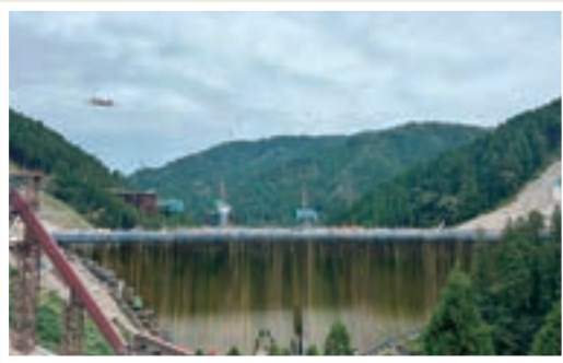
▲足羽川ダム本体工事
