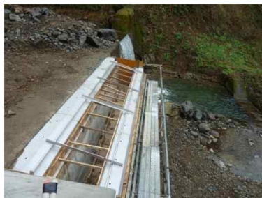
チロリアン取水装置の上面
