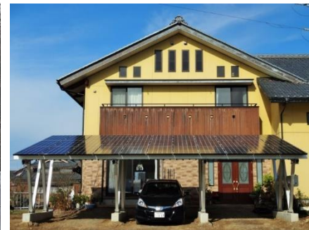
ソーラー一体型カーポート (積雪1.5m対応) (提供：(株)北陸サンアビリティ)
