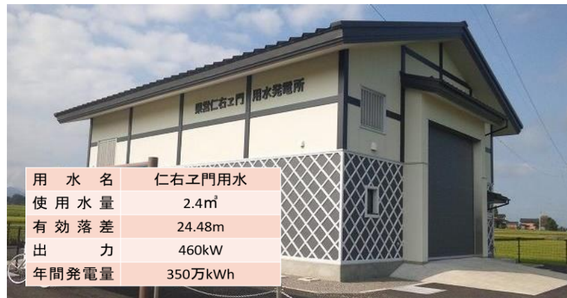
仁右エ門用水発電所（富山県）
